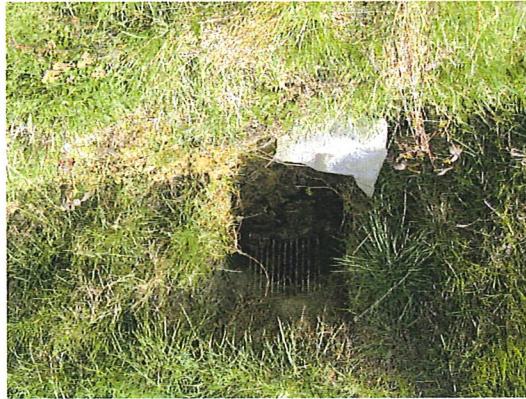
Drainage des terrains agricoles
