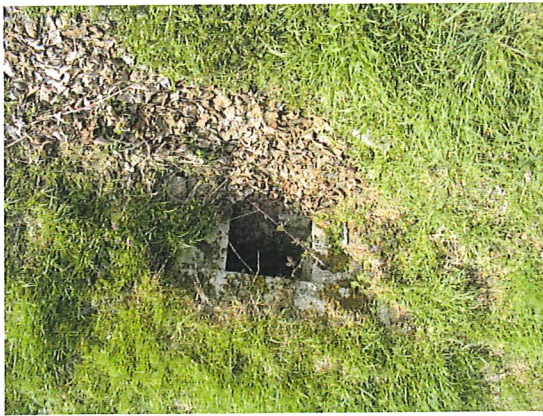
Ouvrage de traversée sous la route de Châteaudun
