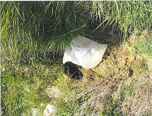
Buse DN300 traversant la RN 10
